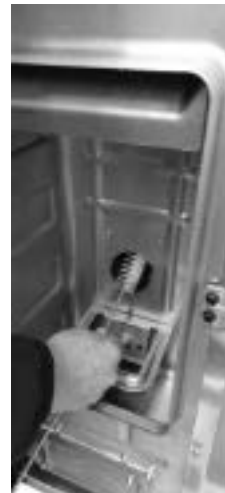
Fig. 37 - Rengöring med piprensare
